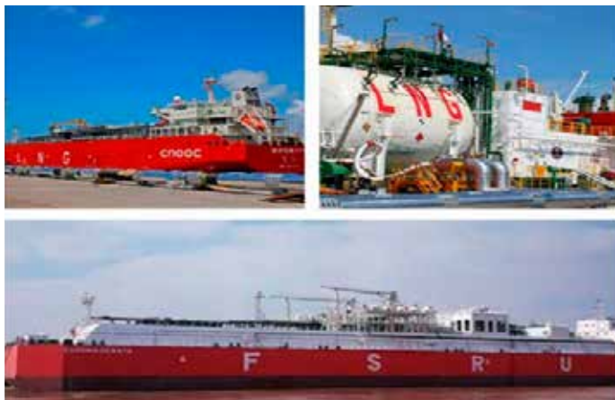
FSRU Karunia Dewata menggantikan FSU (Floating Storage Unit) HYSY milik CNOOC.
